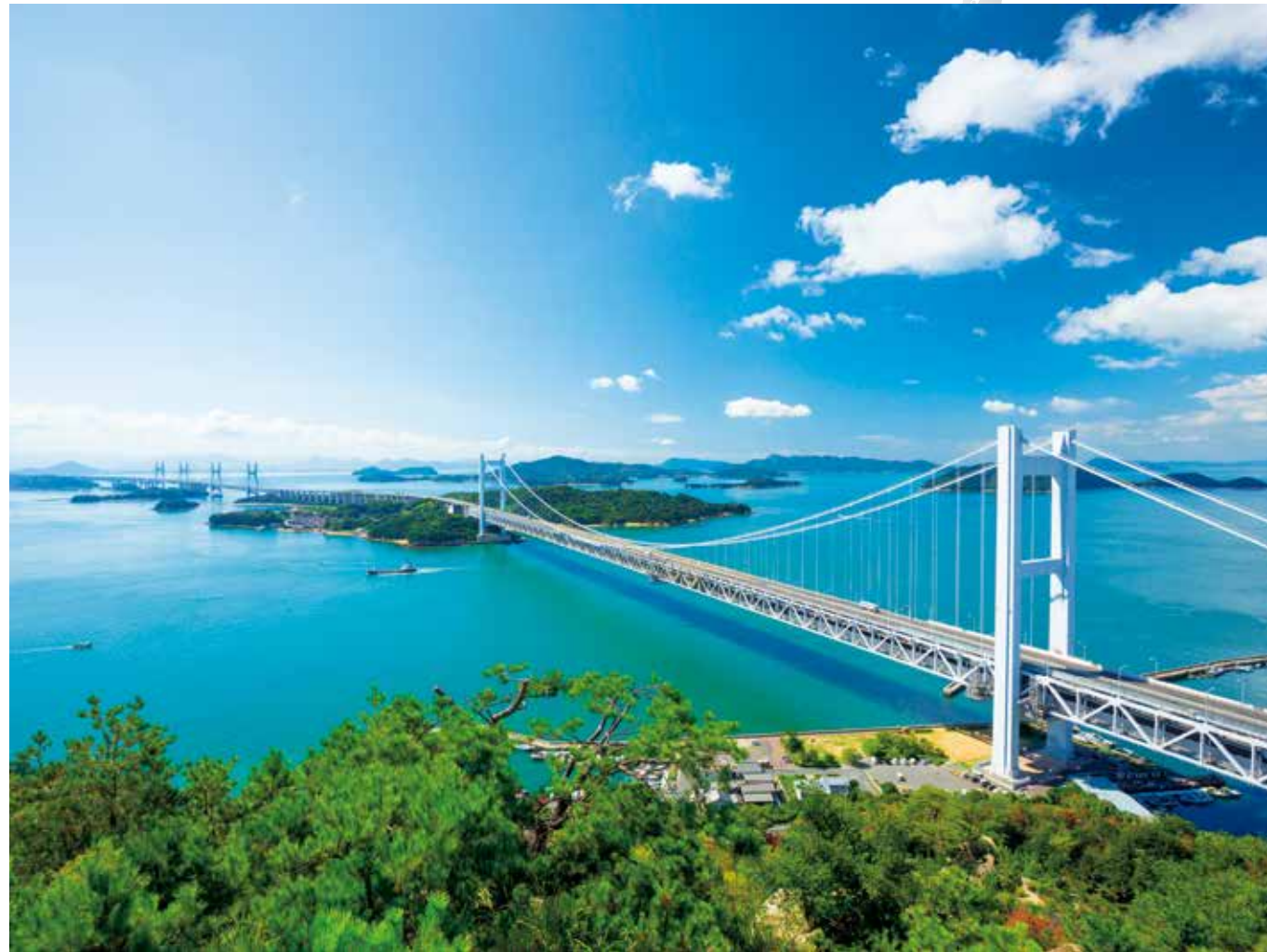
鷺羽山より瀬戸大橋
