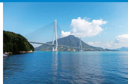
多々羅大橋
